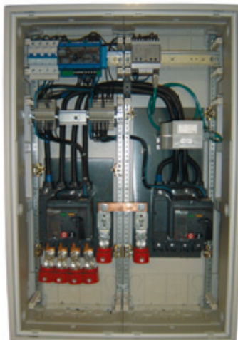
Aufbau eines NA-Schutzes mit zusätzlich integriertem Brandschutz durch DMRCD 1B+, DCT 70B+ und DTCC-1 (links: Firma Gustav Hensel GmbH & Co. KG, rechts: Firma ABN Braun AG)
